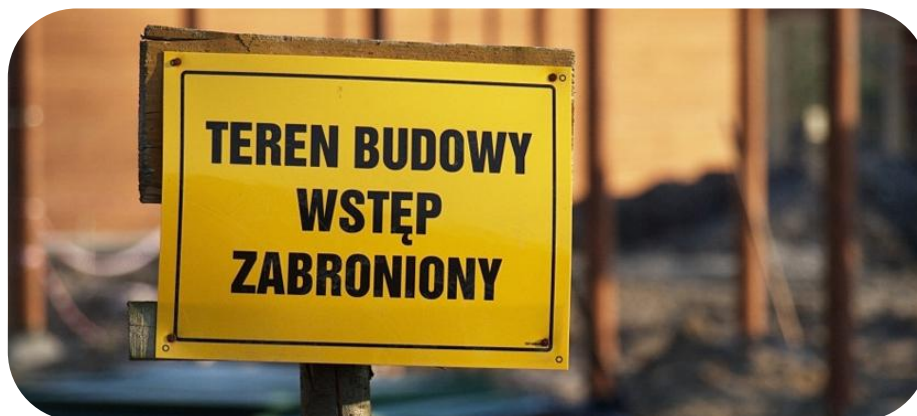
Tablica informacyjna na terenie budowy muzeum w Pustkowie Źródło: www.wsubiektywie.pl
