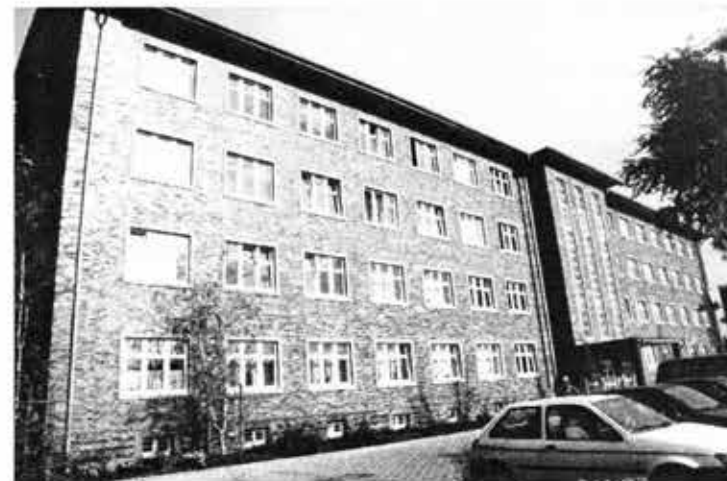
Direktionsgebäude der Arado Flugzeugwerke Wittenberg, heute Finanzamt
